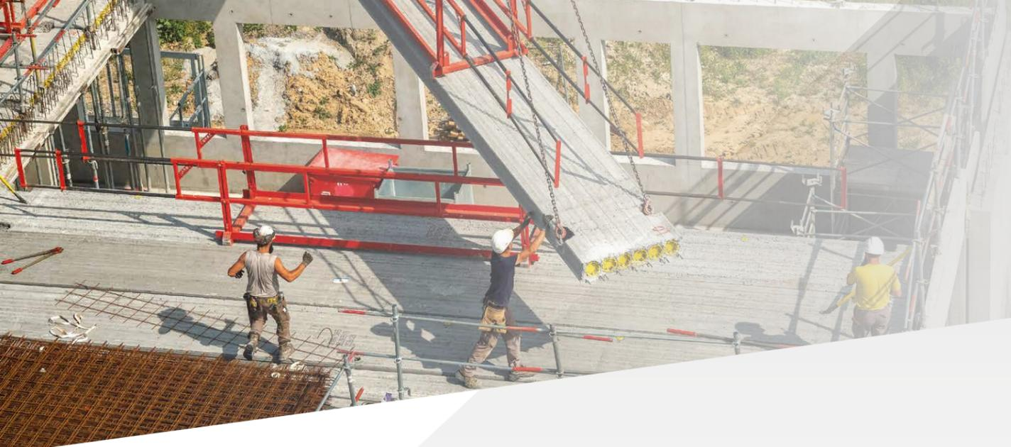
**Jusqu'à 2 fois plus léger qu'un plancher en béton plein** grâce aux alvéoles, le plancher dalle alvéolée contribue à un allègement de la structure pour une réduction du nombre de porteurs intérieurs.
