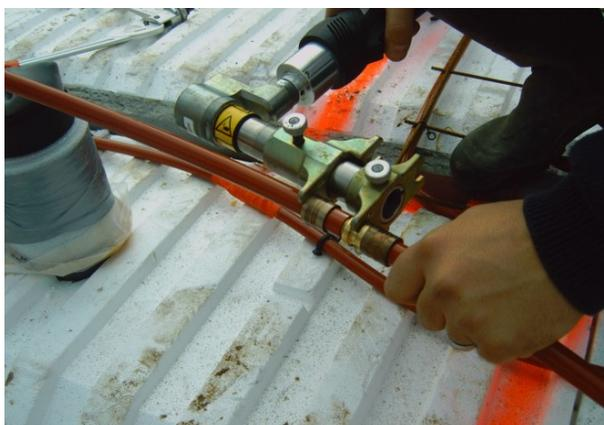
Les raccords à sertir axiaux REHAU sont indémontables, la réalisation du sertissage ne peut être effectuée que grâce aux outillages REHAU et comme suit :
