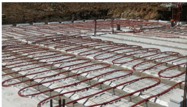
Les jonctions entre les trames et les tubes de raccordement allant au collecteur sont exclusivement réalisées avec les raccords à sertir axiaux indémontables REHAU conformément aux certificats N° 81349 et N° 81350 (ou sa version en cours de validité), à l'aide des outillages spécifiques fournis par Rehau. Les raccords sont protégés du contact direct avec le béton d'enrobage avec un ruban adhésif.
