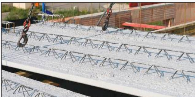
Le levage doit être réalisé à l'aide d'un matériel de manutention conformément aux indications portées sur le plan de pose. Les systèmes de levage par élingues à pouliées ou par palonnier sont recommandés car ils assurent un auto-équilibrage à chaque point d'accroche et la sécurité sur le chantier.
