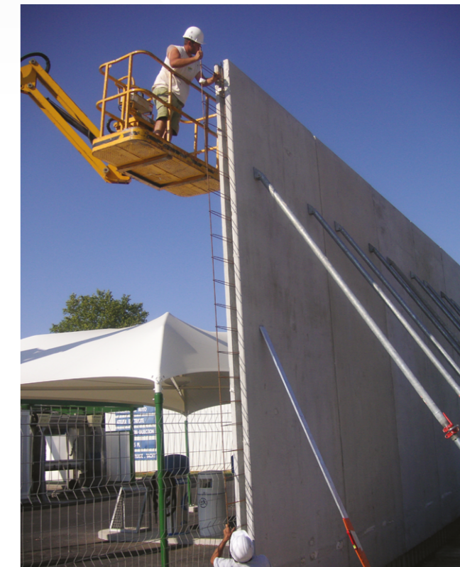
Exemple de mise en place des armatures d'éclissage
