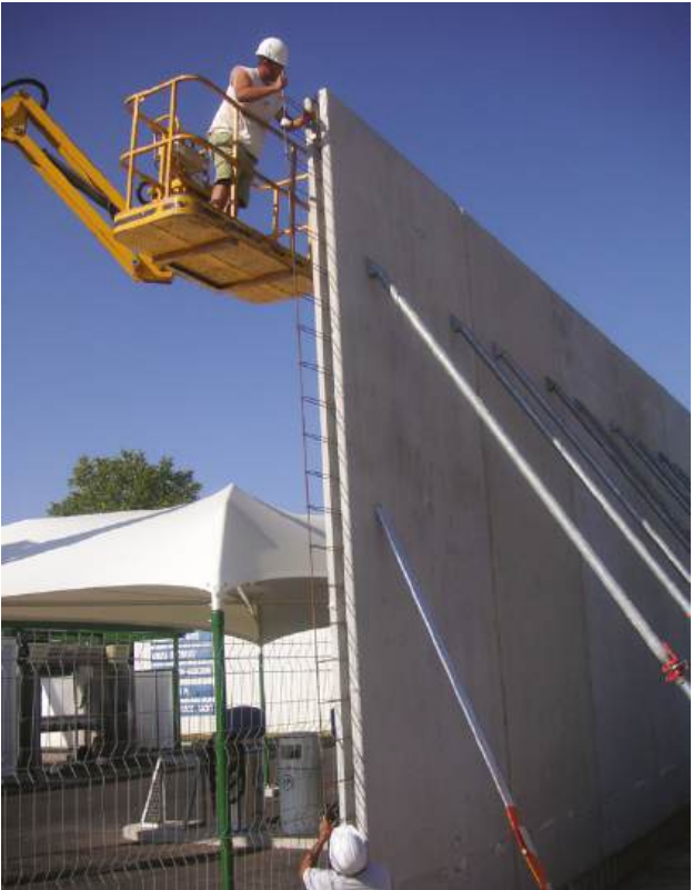
Exemple de mise en place des armatures d'éclissage
