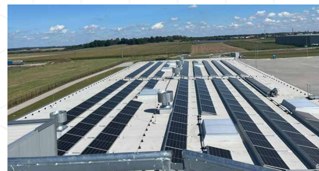
Site de Chrzanów – Panneaux photovoltaïques en toiture d'une puissance de 50 kWc (autoconsommation)
