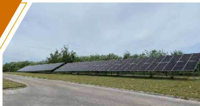
Site de Mszczonów – Panneaux photovoltaïques au sol d'une puissance de 50 kWc (autoconsommation)
